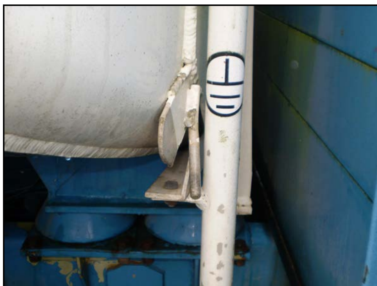
Slika 47. Pločica za priključenje uređaja za odvod statičkog elektriciteta
